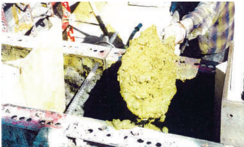
Resim 3.21. Kohesiv Karışımın İşlenebilme Güçlüğü Picture 3.21. Workability Difficulty of Cohesive Mixture
