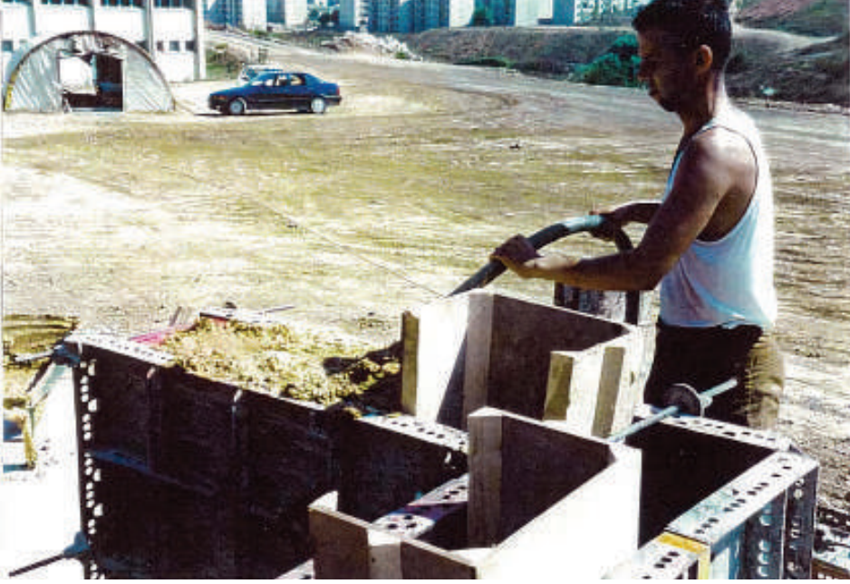
Resim 3.13. Akıcı Plastik Kıvamlı Karışımlarda Şişe Vibratör Kullanılması Picture 3.13. Use of Spud Vibrator in Mixtures at Fluid Plastic Consistency
