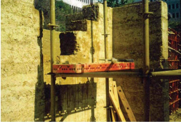
Resim 3.24. Hatalı iş Derzinin Onarılması
