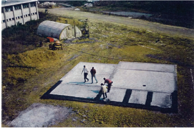
Resim 3.31. Duvar Alt Yüzeylerine Su Yalıtımı Sürülmesi Picture 3.31. Water Insulation Applied to Lower Surfaces of Wall
