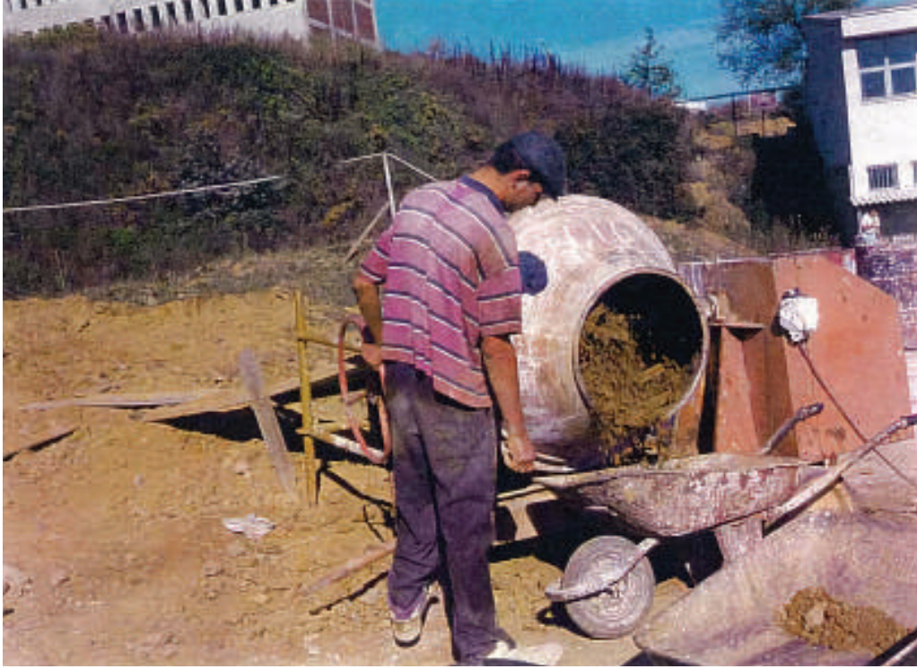
Resim 3.4.Betoniyerin Boşaltılması Picture 3.4.Discharge from Concrete Mixer
