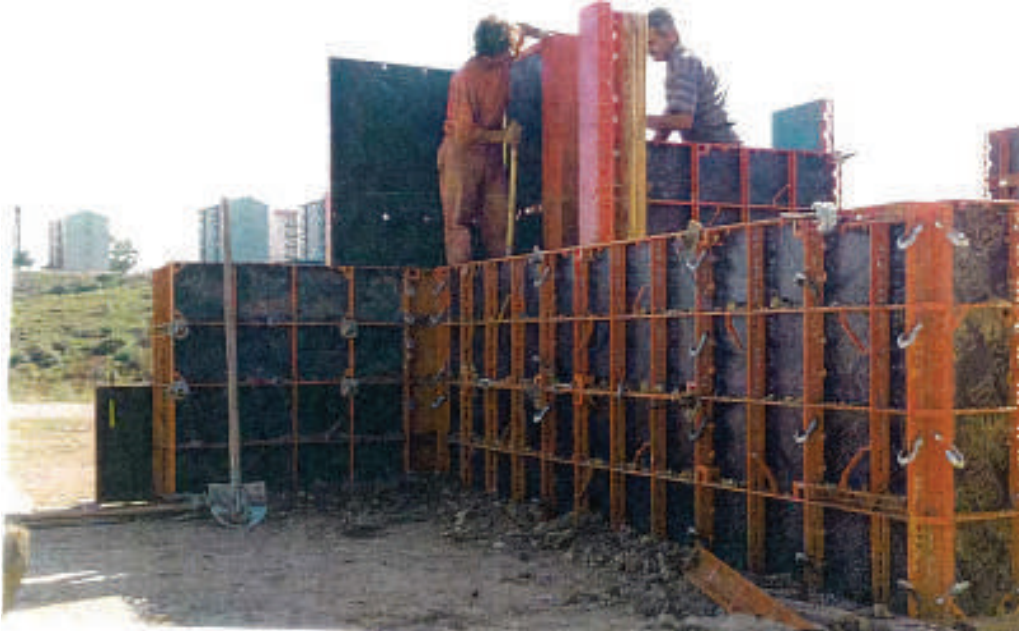
Resim 3.7. Kerpiç Duvar Dökümü İçin Kullanılan PERi Hand-set Sistem Kalıpları Picture 3.7. PERI Handset System Moulds Used for Adobe Wall Casting
