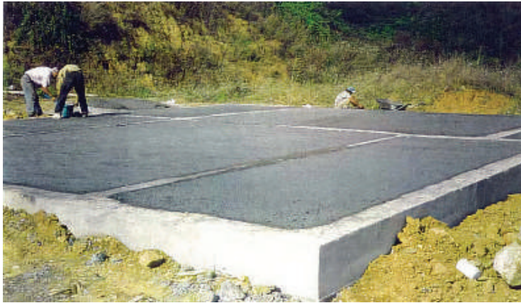
Resim 3.30. Zeminin Sıkıştırılması Picture 3.30. Compression of the Ground
