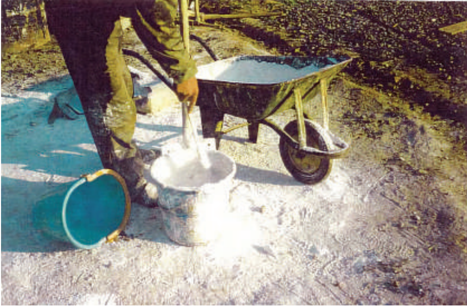
Resim 3.5. Alçı +Kireç+Su Oranları El Arabası ve Kürek Birimlerine İndirgenmesi Picture 3.5. Turning Gypsum + Lime + Water Rates into Hand Chart and Shovel Units
