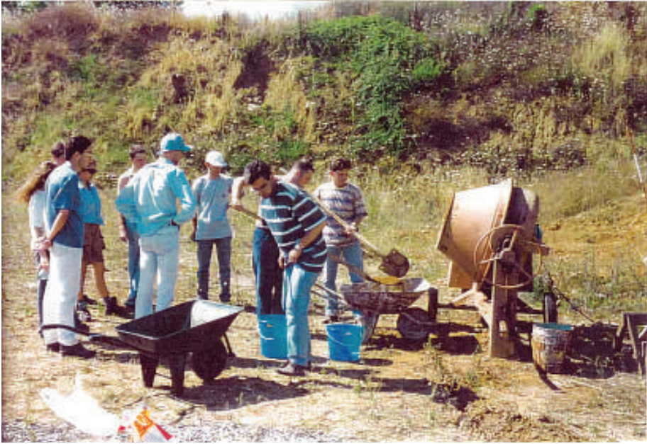
Resim 3.2. Toprağın Küreklerle Betoniyere Yerleştirilmesi
