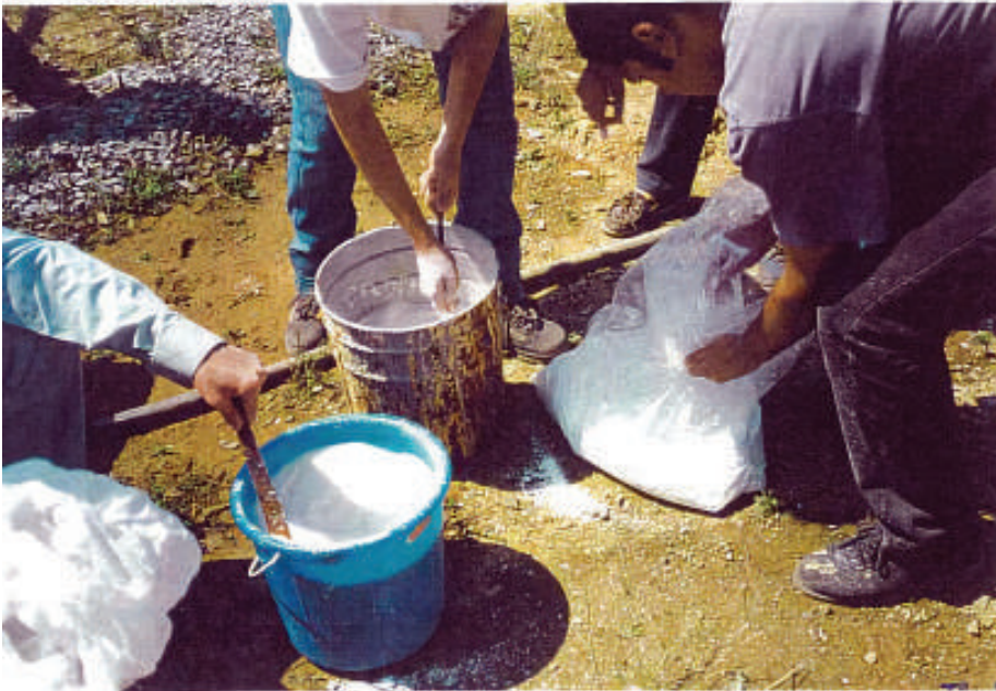
Resim 3.3. Ölçeklendirilmiş Kovalarda Alçı + Kireçli Su Karışımının Hazırlanması
