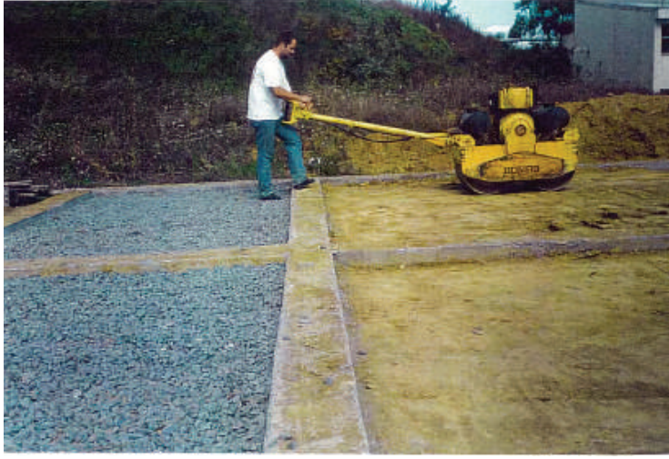
Resim 3.29. Zeminin Sıkıştırılması Picture 3.29. Compression of the Ground
