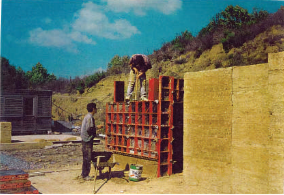
Resim 3.10. Kalıba Dökülen Harcın Balyozla Sıkıştırılması
