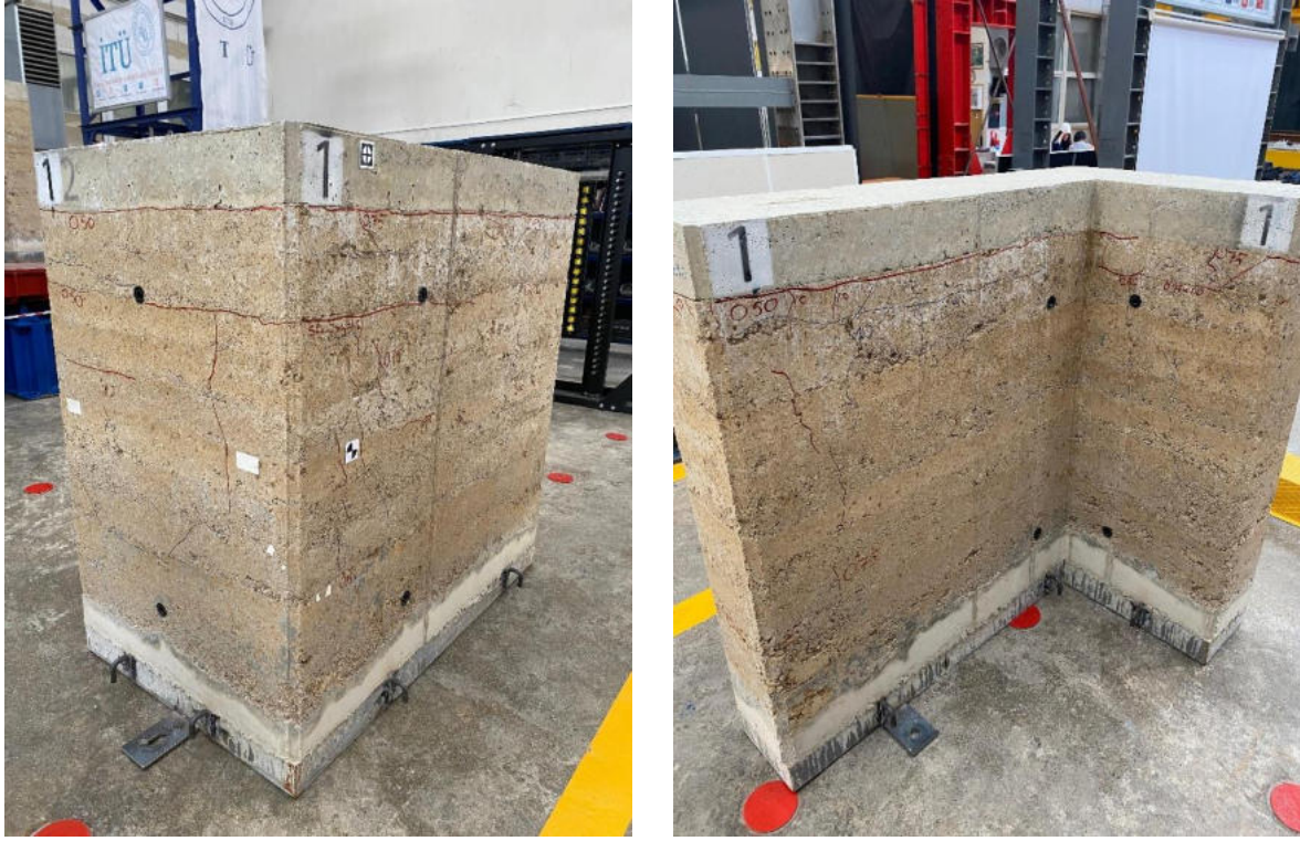
Şekil 3.1. LSM1'in deney sonundaki çatlak gelişim ve yapısal hasar durumu.
