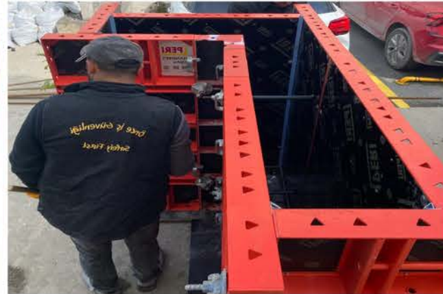
PERİ Kalıp Yağlama
