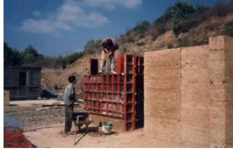
(R.32) Beton Kalıbı
