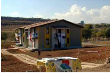
R16 gap sıvasız duvar
