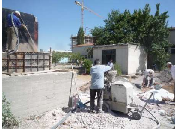
(R.53) Shotcrete ile dolgu
