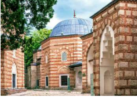
(R.12) Taş+ tuğla tarihi yığma yapı
