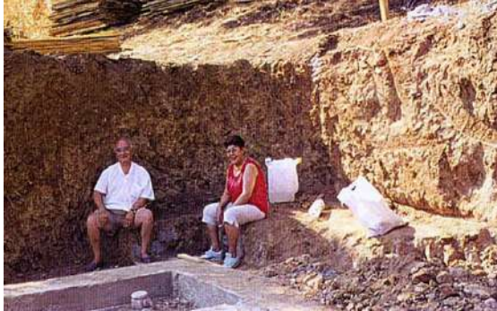
(R.33) Altınoluk Hafriyat Toprağı İnşaat
