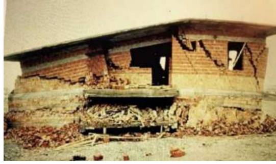
(R.13) Depremde köşegen kırılan önlemsiz yığma yapı
