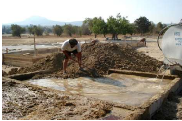
(R.11) Kerpiç dinlendirme havuzu
