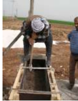
R20 tokmakla alçı-kireç stabilizasyonu
