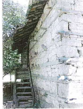
Resim.1 İki eksenli yük altında yatay donatı uygulanmış kerpiç duvarın (BI) Resim.2 Alanya KöprülÜ kanyonda taş yığma yapı yatay hatılları (BI)
