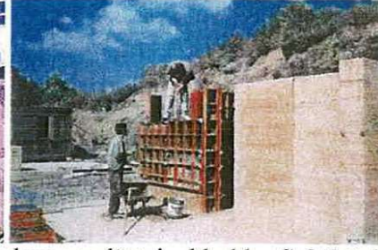
Şekil.3 betoniye Şekil.4 kerpiç duvar endüstriyel kalıbı Şekil.5 duvara tokmaktama
