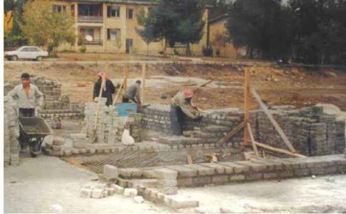
Resim 7.3. Beton Parke Taş Tesislerinde Üretilen Alker Bloklar ile Yığma Duvar Örülmesi
