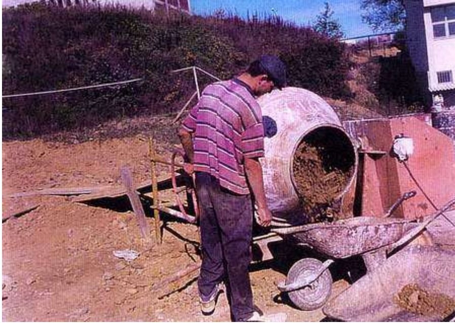
Resim 5.3. Alker Malzemesinin Betoniyerde Karıştırılıőı.
