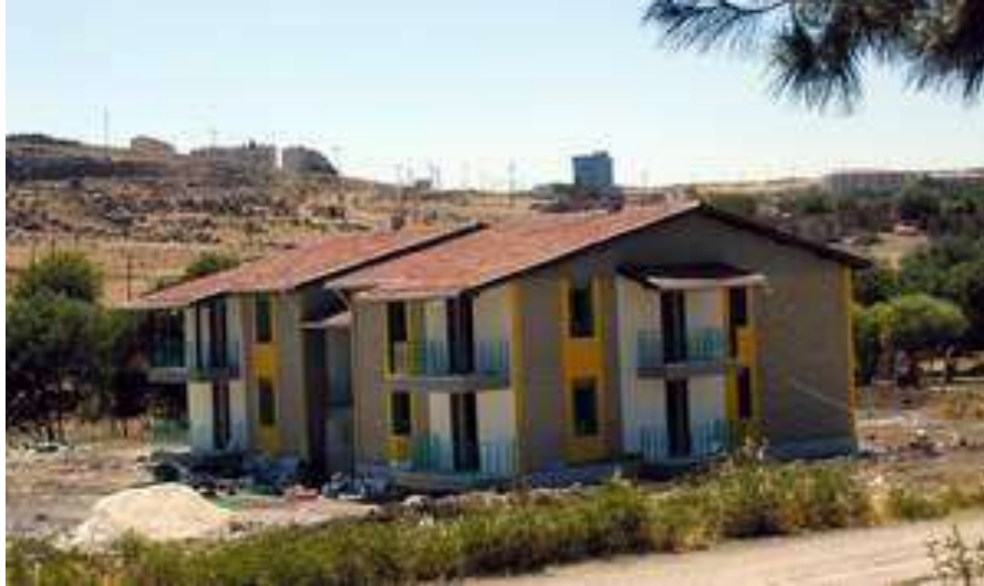
Resim 7. 1. İTÜ GAP Alker Pilot Yapısı'nın Haziran 2000 Görünüşü
