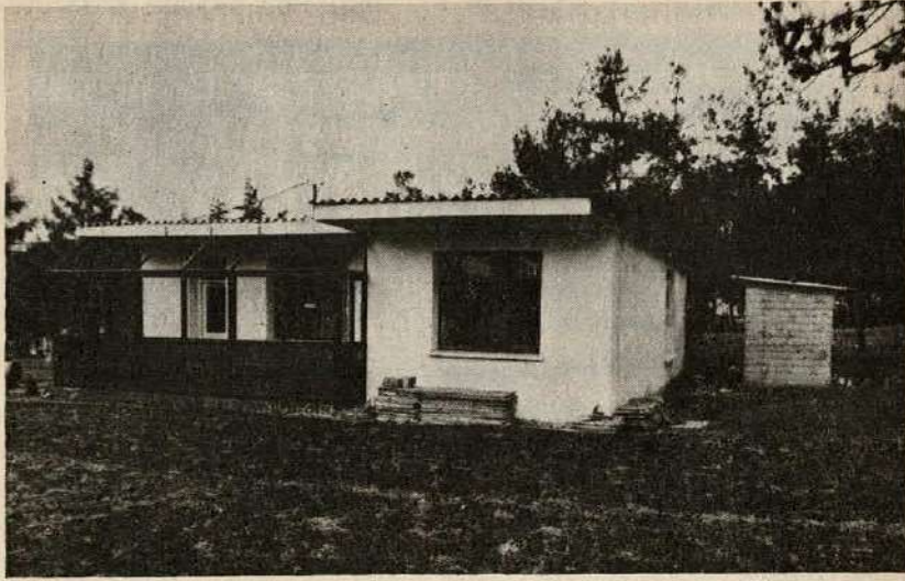
Şekil 3 : İTÜ Ayazağa Kampüsünde deneme evi (yığma Alker yapı denemesi)
