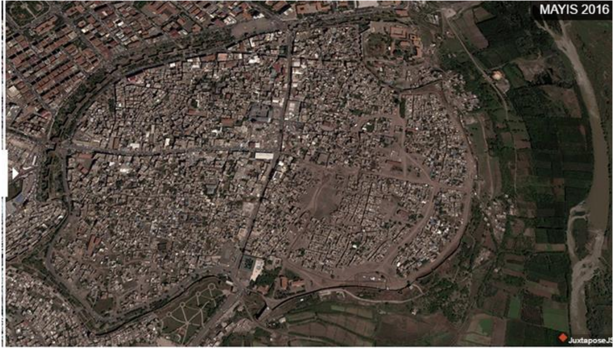
Şekil 4. Sur İlçesi yıkım sonrası hava görüntüleri [www.arkitera.com]
