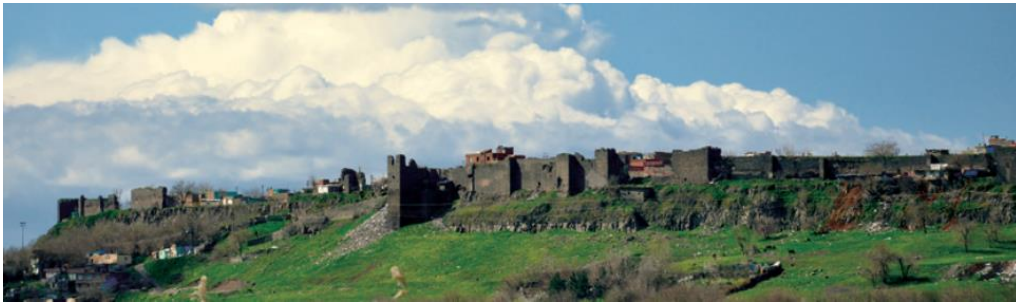
Şekil 2. Kale ve Surların doğu görünüşü
