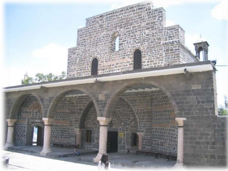
Şekil 10. Meryem Ana Kilisesi'nin batı görünüşü (onarımdan sonra)
