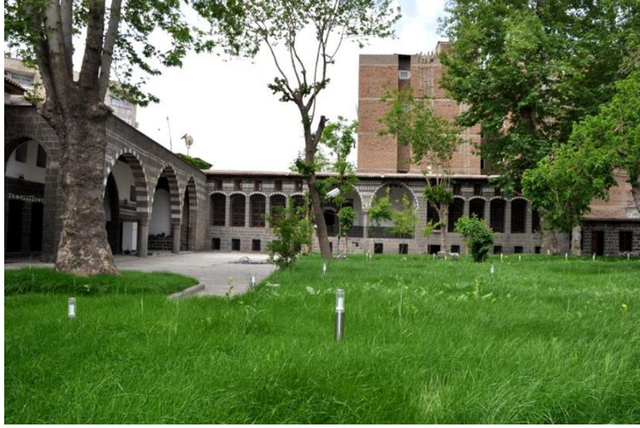
Resim 9. İskender Paşa Konağı iç cephe örneği ( http://www.diyarbakirkulturturizm.org/UserFiles/202998DSC_0006.JPG 2016,Aralık)
